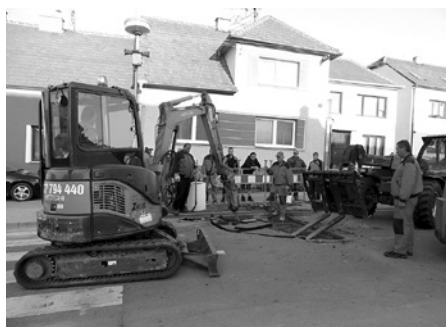
První minuty práce na rekonstrukci přechodu pro chodce před pekárnou v ulici Dlouhá.
