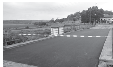
Opravený most přes Trkmanku v ulici Pod Břehy.
