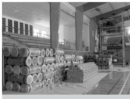
Rekonstrukce tělocvičny, prozatím složený izolační materiál.
