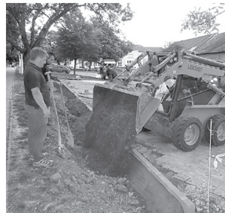
Ulice Dlouhá – oprava parkoviště podél kostela a hřiště.
