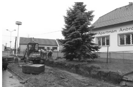
Oprava chodníku v ulici V Sadech byla zahájena dle plánu.
